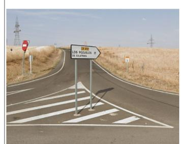
En cuanto a la señalización longitudinal, en la carretera CR-4121, estas marcas no existen o están en condiciones muy deterioradas. Por lo tanto, se propone una rehabilitación completa de las marcas viales: líneas continuas para los márgenes y líneas discontinuas para el eje central.
