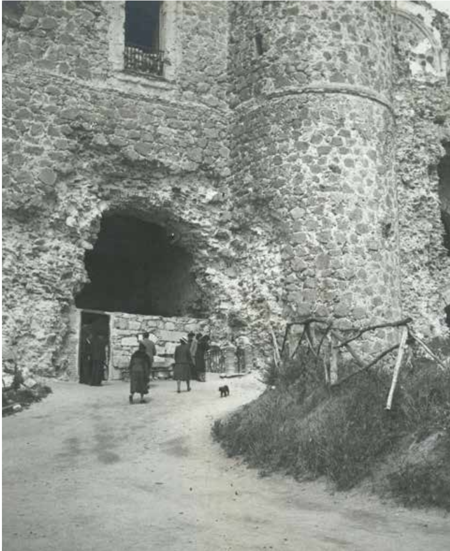
9. Grupo de visitantes en el acceso a las ruinas por la fachada este en los años 40. Biblioteca Virtual de Defensa
