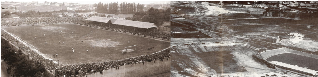
Figura 2.3. A la izquierda, el antiguo campo de fútbol de Chamartín en 1924. A la derecha, el inicio de las obras de lo que es hoy el Santiago Bernabeu, junto con el antiguo Chamartín, en 1944.
