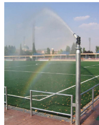
Figura 3.11. Riego perimetral con cañones.
