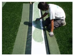
Figura 2.7. Sistema de unión de juntas de césped artificial mediante geotextil
