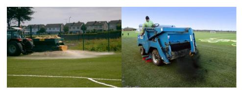
Figura 2.10. Sistema de instalación del relleno del césped artificial. Instalación de arena de sílice (izquierda) y de caucho SBR (derecha)
