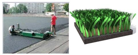
Figura 2.5. Proceso de instalación de capa elástica "in situ" (izquierda) y corte transversal de un campo de fútbol de césped artificial con capa elástica (derecha)
