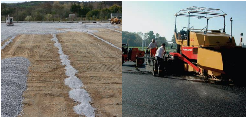
Figura 1.7. Construcción de sub-base de macadán (Delaney, 2009)
