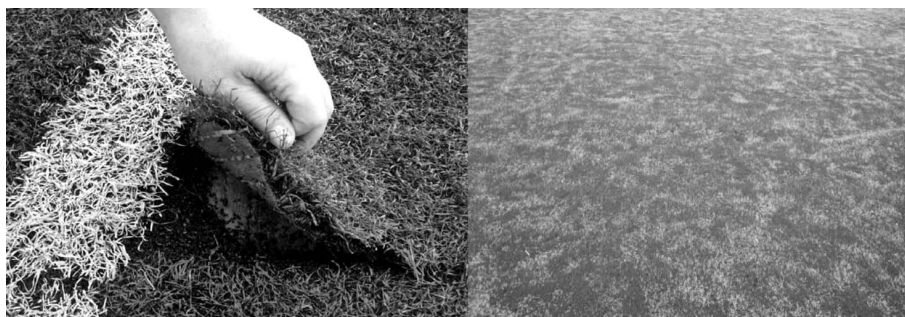
Figura 2.11. Rotura de una junta del césped artificial (izquierda) y exceso de desfibrilación del terreno (derecha)
