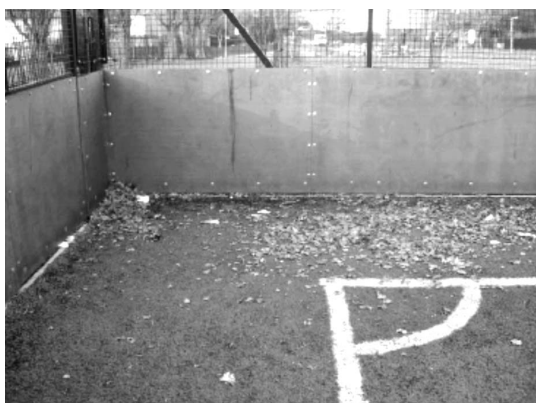
Figura 2.12. Exceso de contaminación en la superficie.
