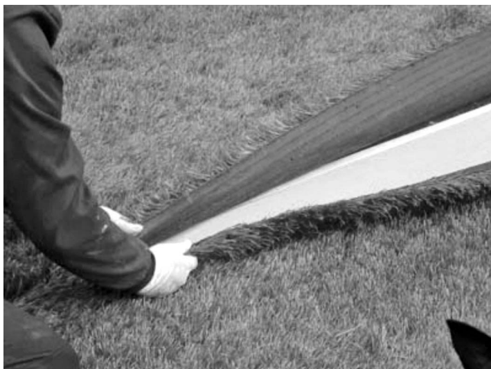
Figura 1.16. Juntas en un pavimento de césped artificial.
