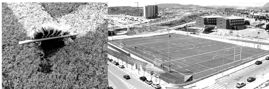
Figura 1.11. Rotura de marcajes (izquierda). Campo con marcajes de Fútbol-11, Fútbol-7 y rugby (derecha).
