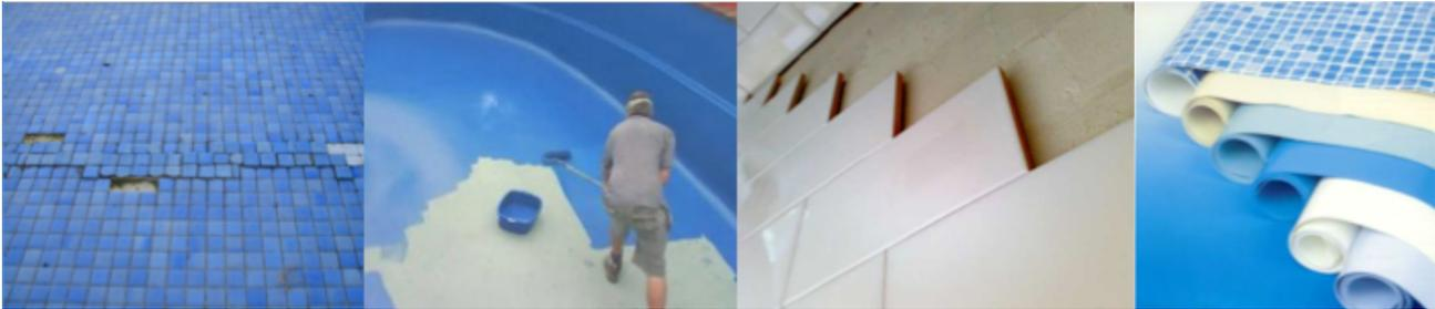
De izquierda a derecha: revestimiento de gresite; vidrio, resina y pintura; cerámica y liner de PVC.
