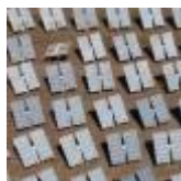
Paneles solares de Tabernas - 07:00
