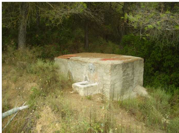
Foto. Depósito de regulación del agua del nacimiento (19-08-2010).
