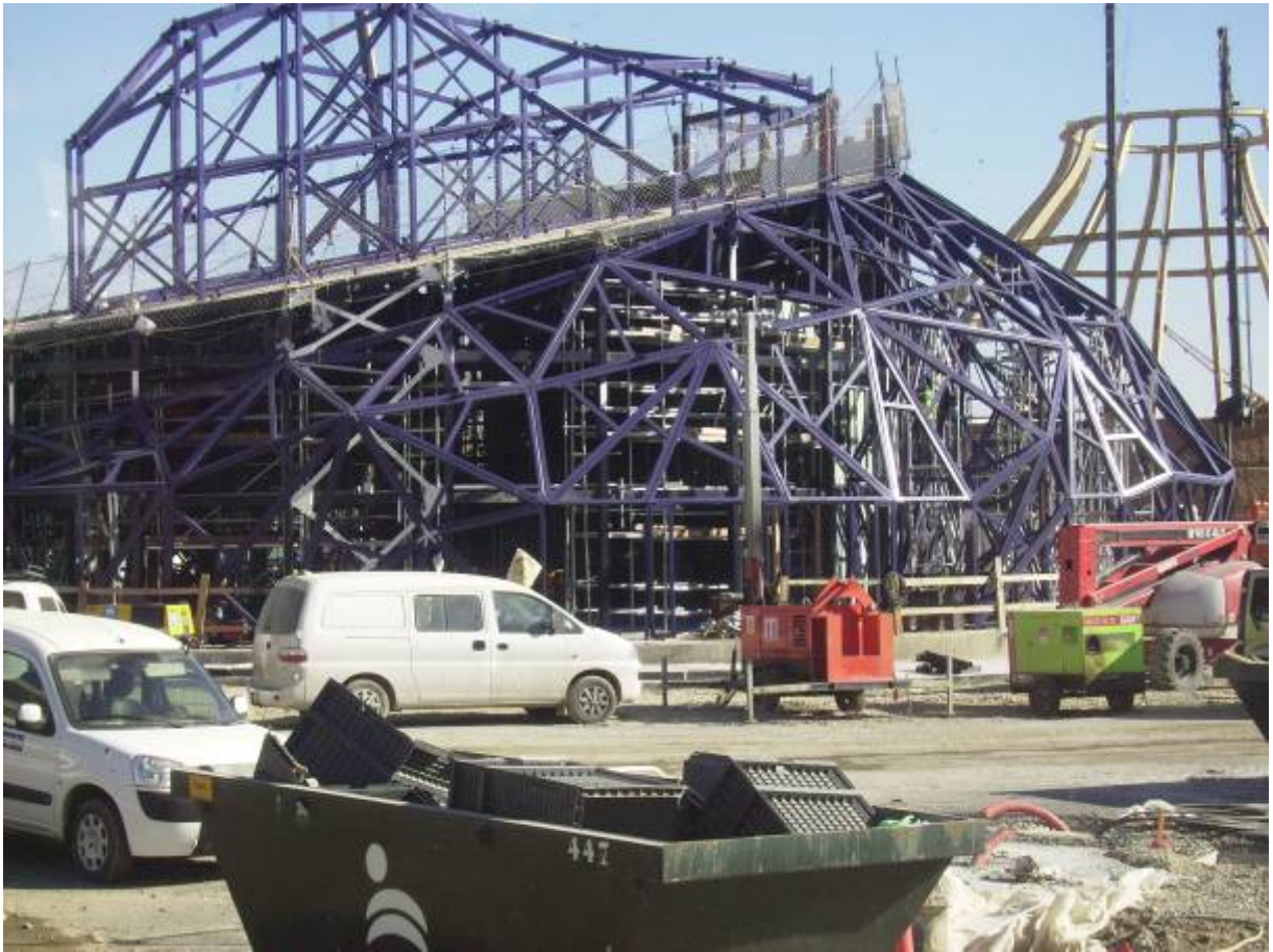
Elevando la estructura de un edificio
