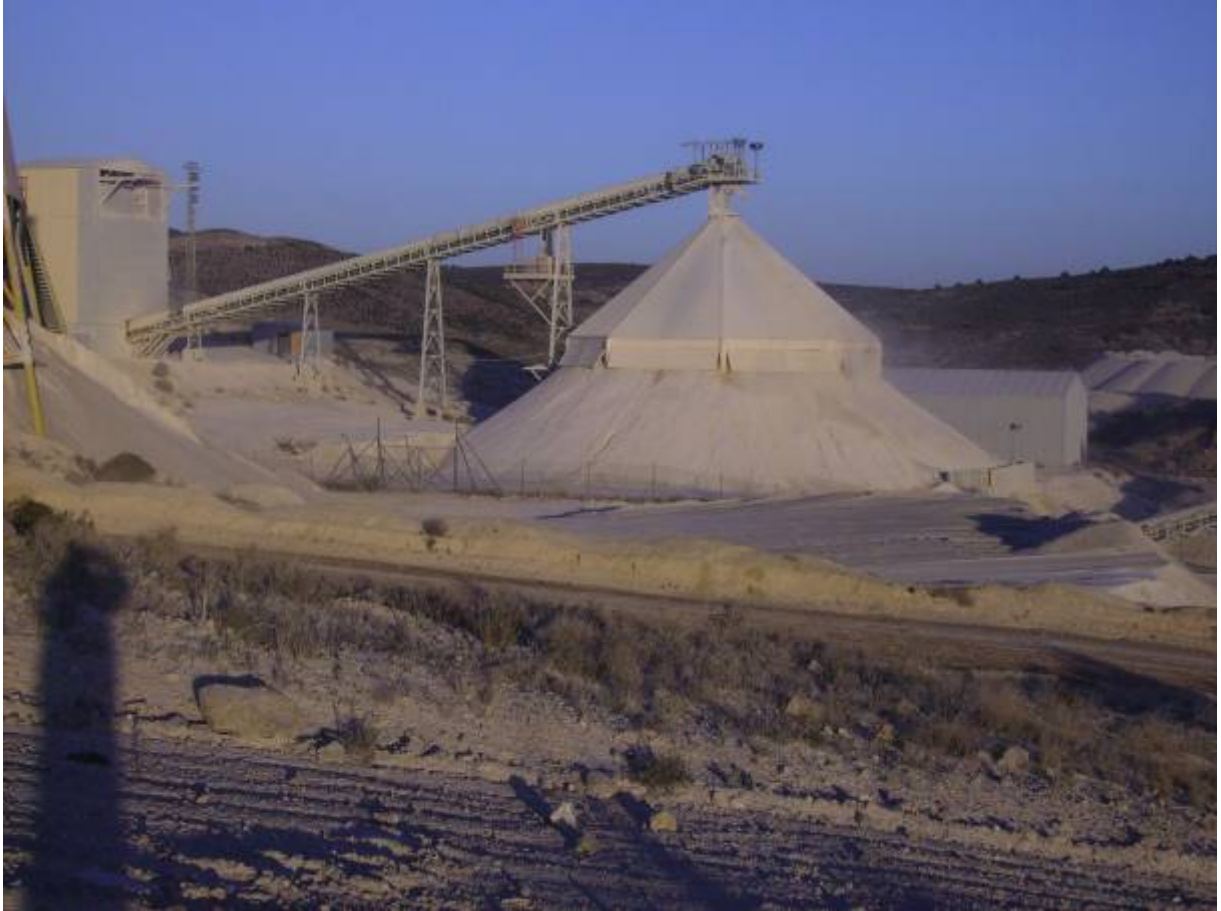
Vista parcial planta de tratamiento
