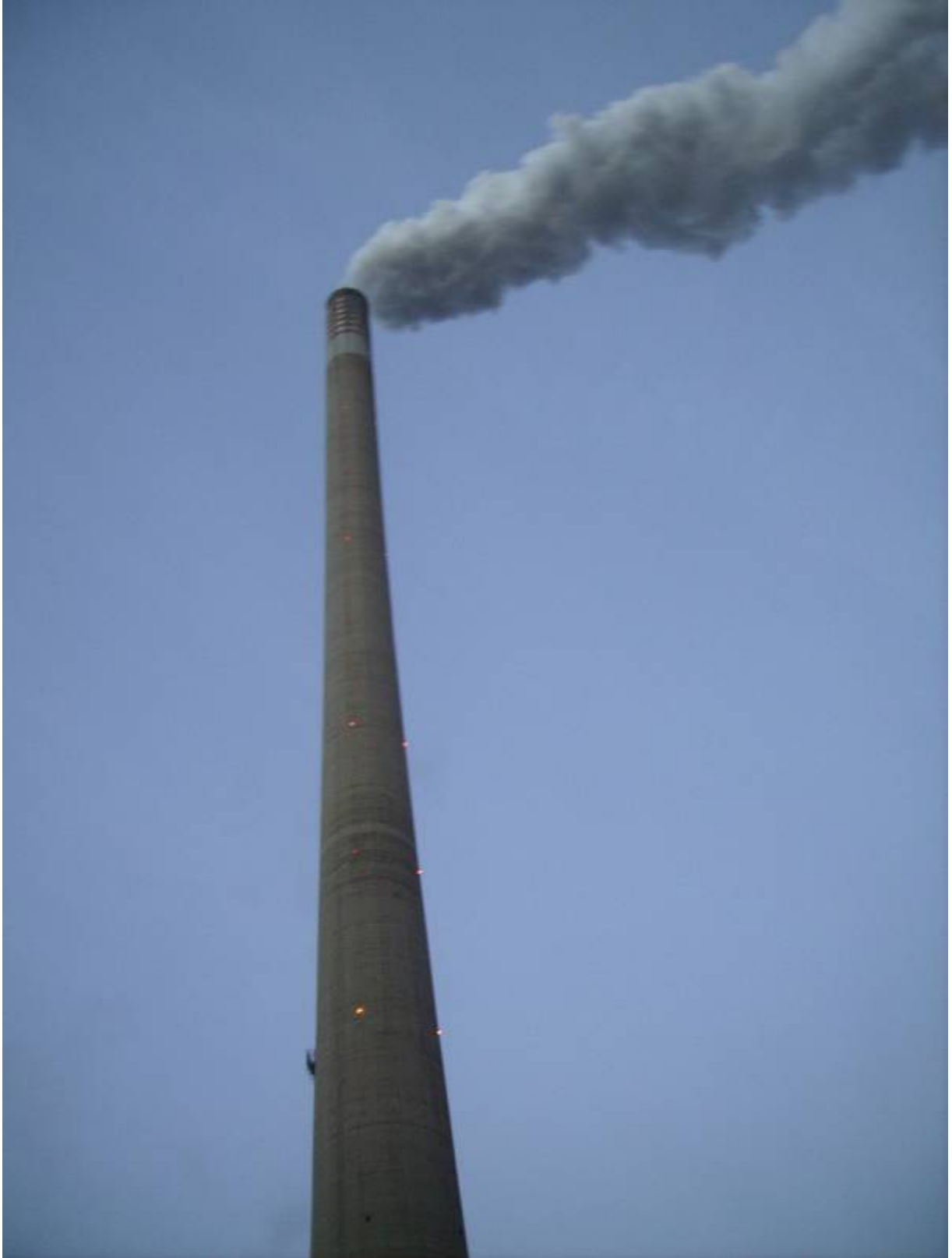
Torre de evacuación de humos (343 m)
