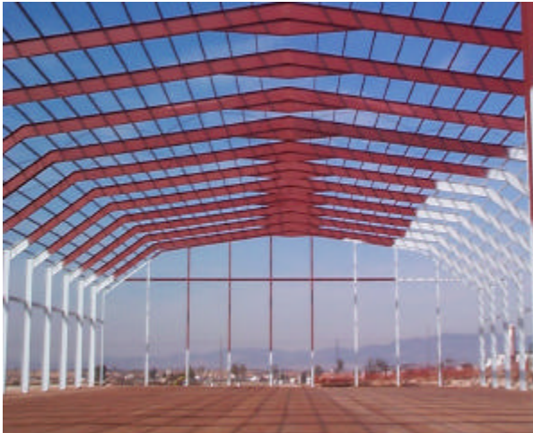
Figura 1: Nave con pórticos poligonales
